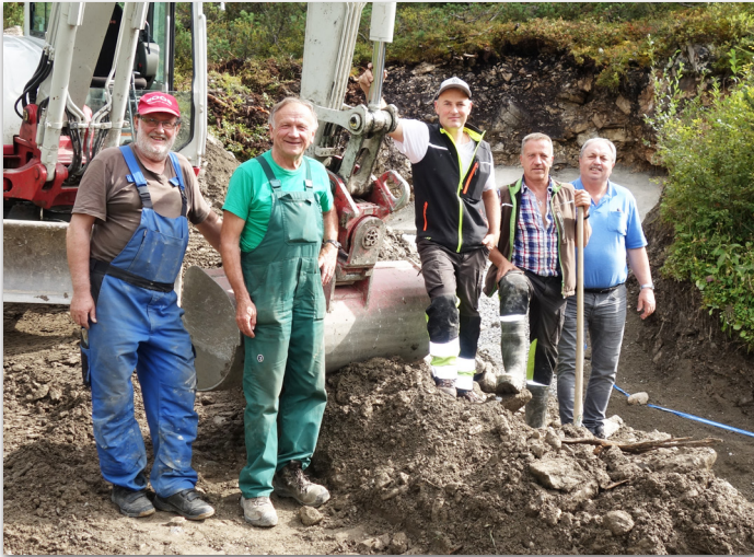
Die Sanierung der Gerlossteinquelle erfolgte unter Aufsicht von Brunnenmeister Engelbert Mayr.
